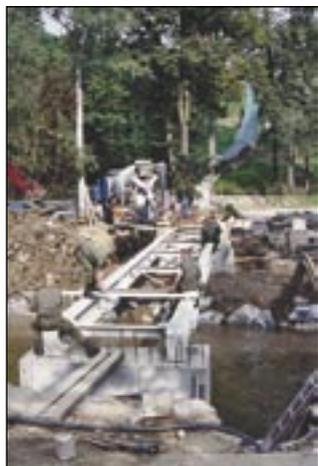
Unsere Aufnahme von den Bauarbeiten entstand am 19. September 2002 und zeigt die Montage der 15,55 Meter langen Stahlträger.
