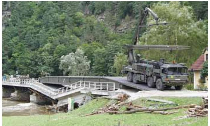
In Zwettl wird im Rahmen der Leistungsschau am 3. und 4. August 2012 eine Pionier-Ersatzbrücke über den Kamp errichtet – hier ein Archivfoto von der im August 2002 erfolgten Errichtung einer Behelfsbrücke bei Thurnberg.
