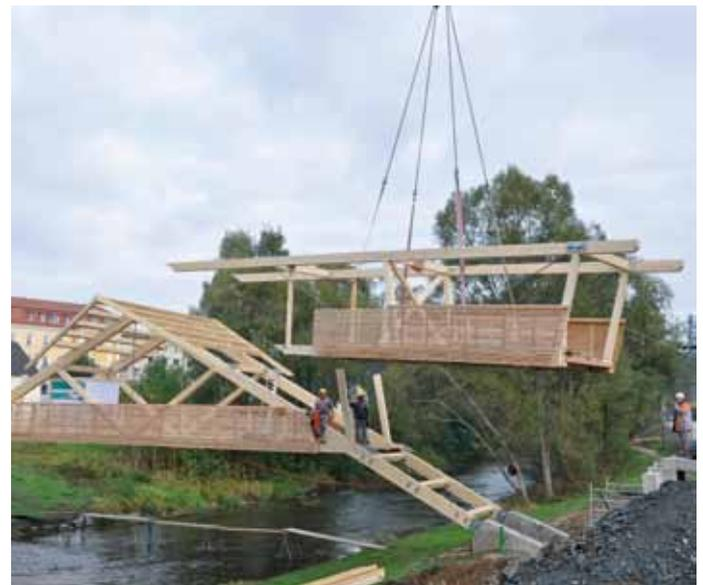
*Die Konstruktionsteile des 35 Meter langen Fußgängersteges wurden in Präzisionsarbeit zu einem „Ganzen“ zusammengefügt.*
