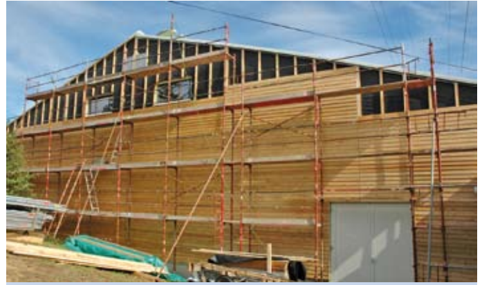
Tennishalle Zwettl vor Abschluss der Sanierungsarbeiten: Die Außenfassade wurde mit Lärchenholz gestaltet.
