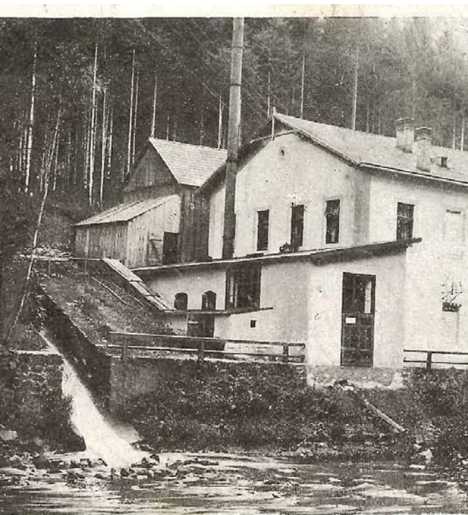
Elektr. Centrale im Kamptal.
